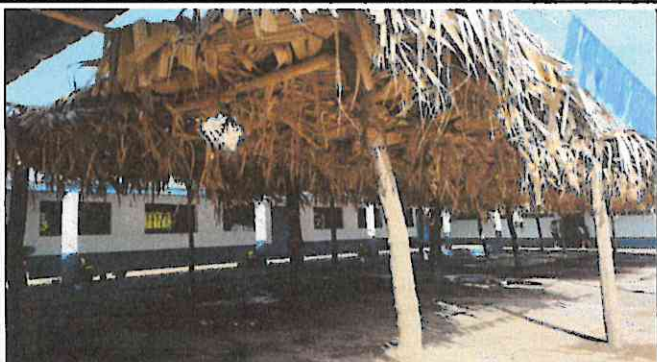
Foto 2: Sustrucción de techo de palma por lámina troquelada, en salón de usos múltiples.
