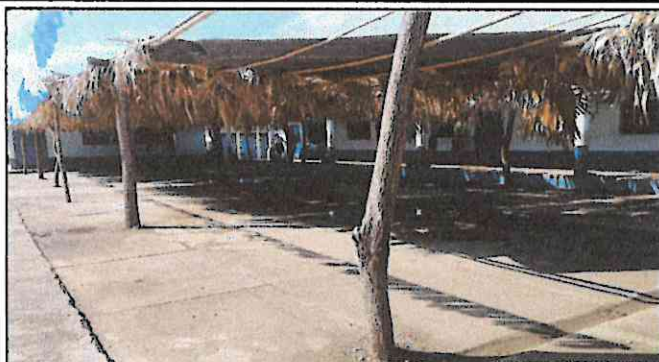
Foto1: Sustrucción de horcones de madera po tubos galvanizados, en salón de usos múltiples.
