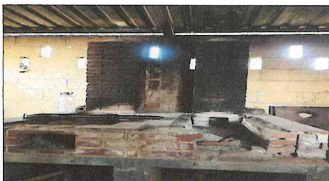
Foto 4: Reparación de Chimenea de cocina, con lámina Galvanizada.
